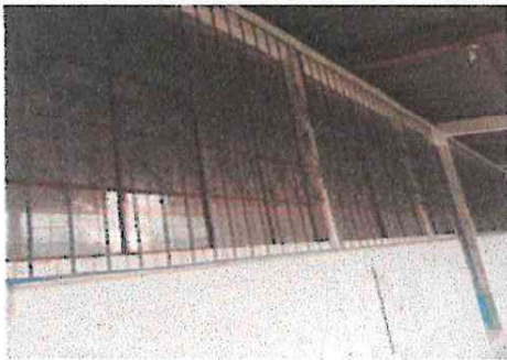
Foto 3: Mantenimiento de estructura de metal de ventanas
