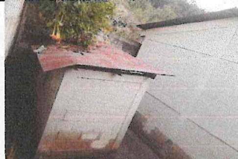
Foto 6: Mantenimiento, a sanitarios.
