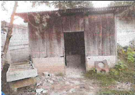
Foto 5: Mantenimiento, estufa rural.
