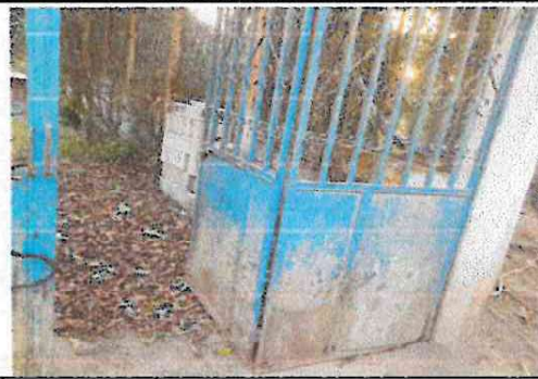
Foto 2: Mantenimiento a portones de metal
