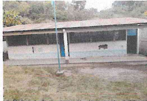
Foto 4: Pintura en muros exteriores e interiores
